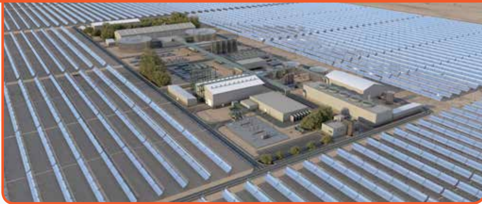
نظرة من الجنوب إلى الغرب مبنى محطة توليد الطاقة والحقن الحراري - الشمسي تصوير: أب متخنييم
